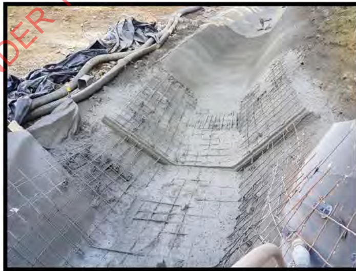
Photo Above: CW6 pour ongoing
