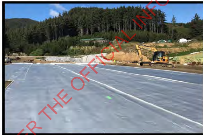
Photo Above: A2 Fill 2B PET layer 1
