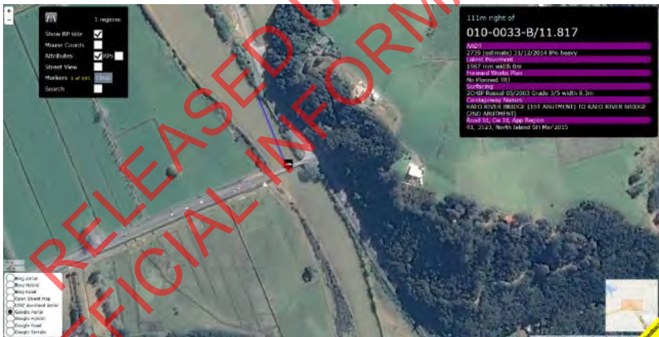
Aerial view of Kao Bridge, SH10
